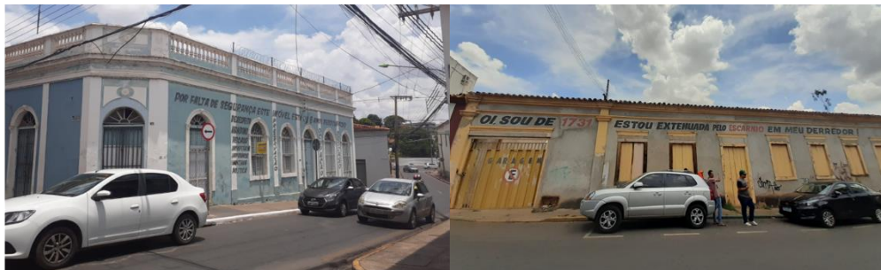
Figura 2 e 3 - Imóveis abandonados do centro histórico de Cuiabá
