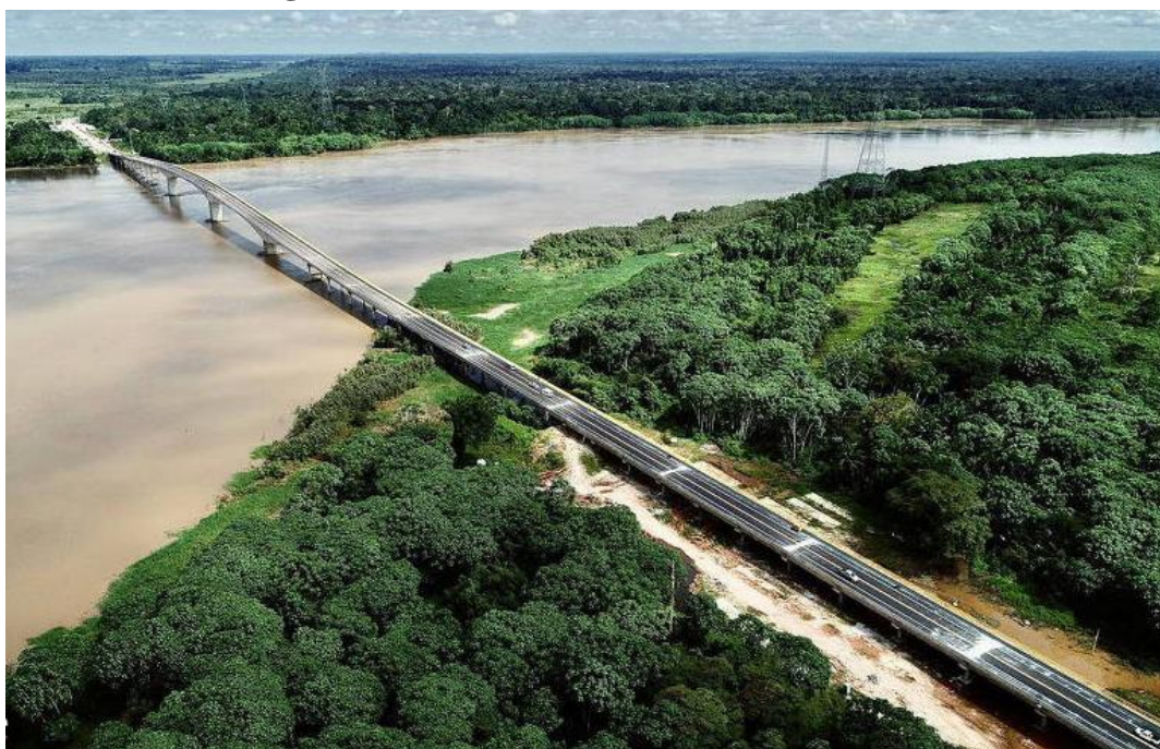
Figura 1 - Ponte do Abunã sobre o Rio Madeira
