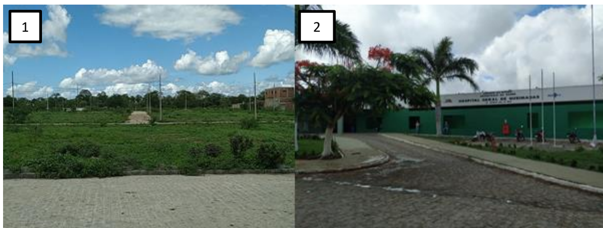
Figura 7 - Imagem 1 loteamento Novo Horizonte; Imagem 2 Hospital Geral de Queimadas Dr. Patrício Leal de Melo
