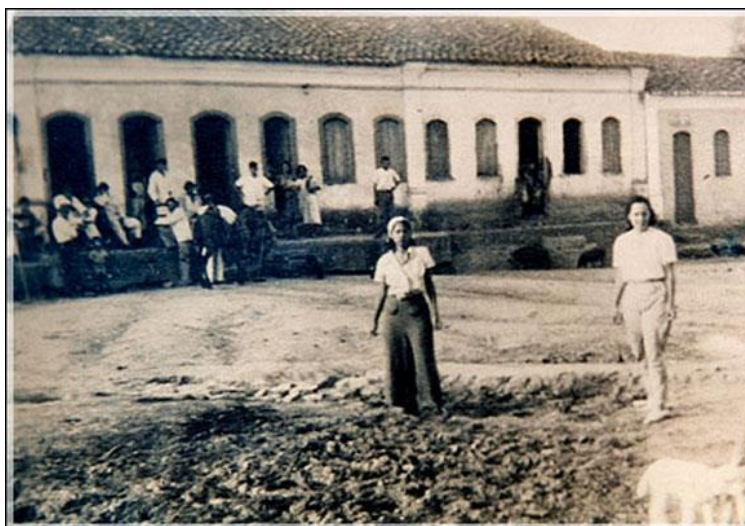
Figura 4 - Praça Nossa Senhora Aparecida no final da década de 1940
